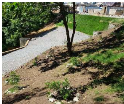
Рисунок 44. Проведение противооползневых мероприятий в месте пересечения р. Котловки и Севастопольского проспекта (2019 год)
