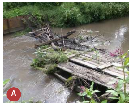
Рисунок 34. Участок русла р.Сходня А. перекрытие русла разрушенным мостом, Б. участок перекрытого русла после расчистки
